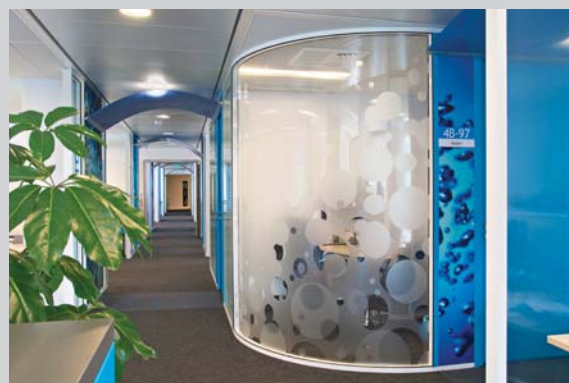
Module vitré toute hauteur avec lisses cintrées
